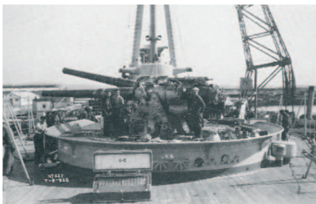
◀ Operarios durante a montaxe dunha torreta no cruceiro Almirante Cervera
